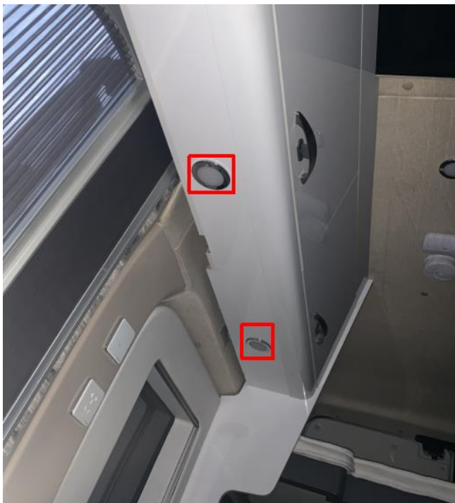
卫生间灯：由卫生间门框处开关控制。
